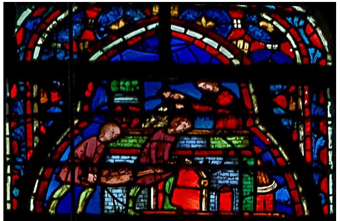
Construction de la Sainte-Chapelle
