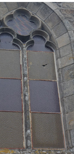
Altérations de la structure en pierre de la baie
